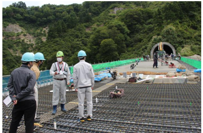
【5号橋梁床版工事の説明】
