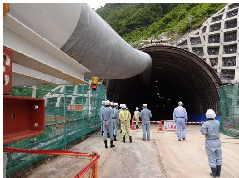
1号トンネル坑口(新潟側) H30. 5撮影
