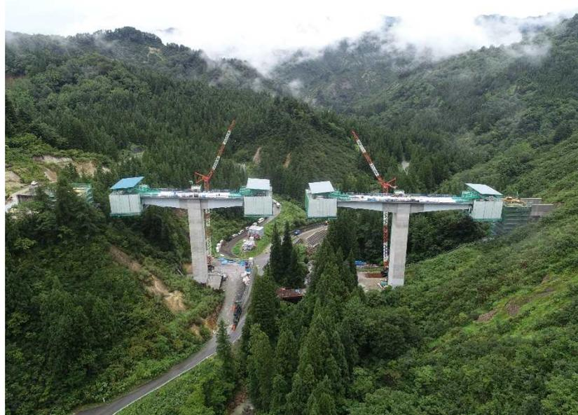
2号橋梁 張出架設 施工状況
