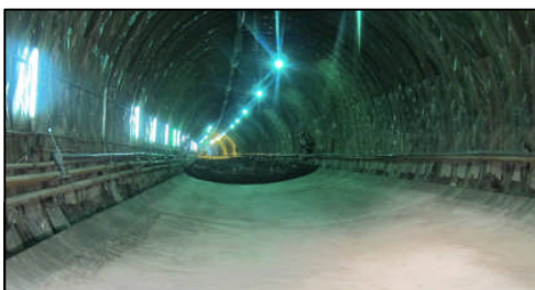
インバート工施工状況
