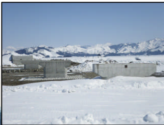
水無大橋施工状況
