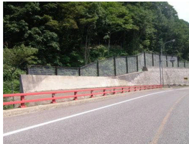
雪崩防止柵施工後（柵高かさ上げ）
