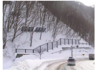
施工後（冬期状況）
