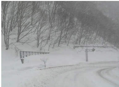
施工前（冬期状況）
