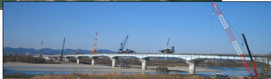
上部工が閉合した信濃川橋梁
