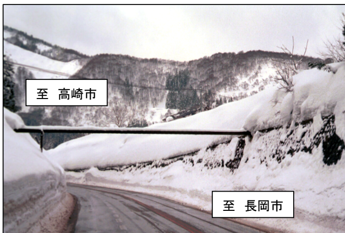
雪による冬期道路幅員狭小の状況
