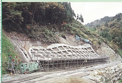
アンカー付法枠工を施工しています。
