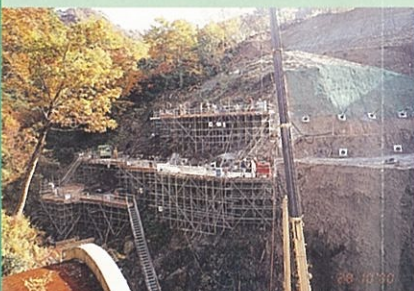
来年のトンネル掘削に向けて坑口付近の施工に着手しています。
