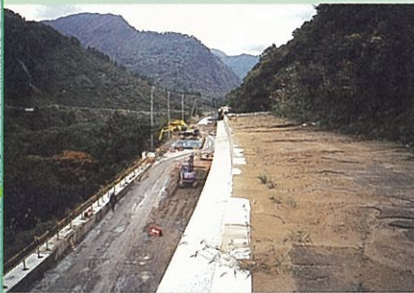
雪崩対策として施行中のスノーシュッド工事
