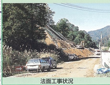
法面工事状況
