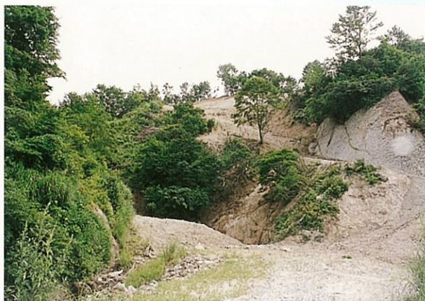
写真右側の山肌が9号トンネルの入口となります。
