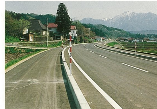
「甲子道路」大松川工区
