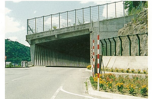
雪崩を防止するスノーシェッド
