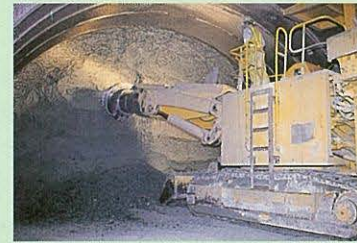
トンネル掘削機械による作業状況
