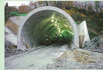
貫通したトンネル
