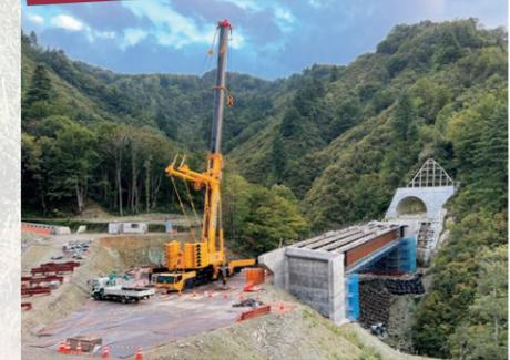
八十里越で最後の橋となるB橋梁を架けています。架設は650t吊りの大型クレーンを使用し、吊り上げる最大のブロックは、長さ40m重さ42tになるため、細心の注意を払いながら施工を進めていきます。
