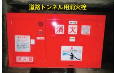
消火栓は、トンネル内で火災が発生した場合初期消火を行うことが出来ます。50m間隔で設置されておりホースの長さ+放水射程距離でトンネル内どこでも消火を行えます。火災検知器は、トンネル内で発生した火災を遠方監視設備等に自動通報する設備です。
