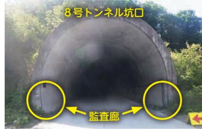
監査廊とは、トンネルの両端にある維持管理用通路です。その通路の下には、消火設備の配水管パイプ及び電気、通信設備用の管路が敷設されています。車両の接触や火災から守るために縁石とコンクリート舗装で防護しています。
