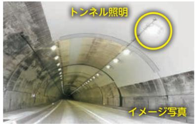
トンネル照明は、トンネル内を安全に走行できる明るさを確保しています。時速50kmを想定して設置しています。センサーにより、屋外の明るさを感じて自動で明るさを変える設備を備えています。
