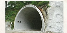
終点坑口(坑外から)
