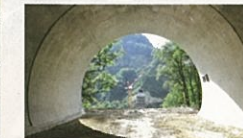
終点坑口(坑内から)
