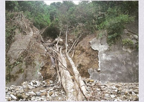
②国道289号ゲートから0.3km地点
