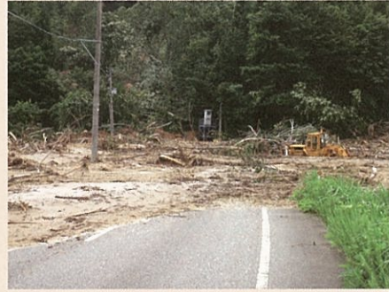
①国道289号大江トンネル新潟側坑口付近
