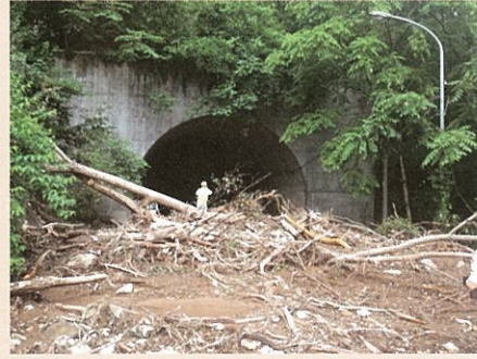
②国道289号大江トンネル福島側坑口付近
