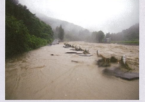
国道289号道路冠水(叶津入叶津地区)
