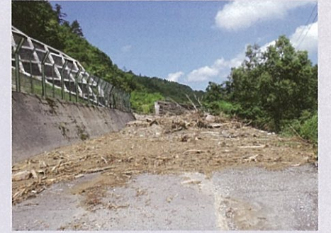
①国道289号ゲート付近
