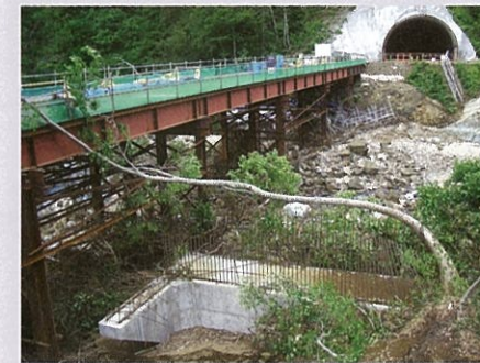
⑧7号橋梁下部その2他工事(A1橋台流出)
