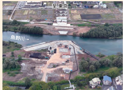
供用済み区間から東京方面を望む (R6-8国道17号新浦佐大橋(渡河部)下部その3工事)
