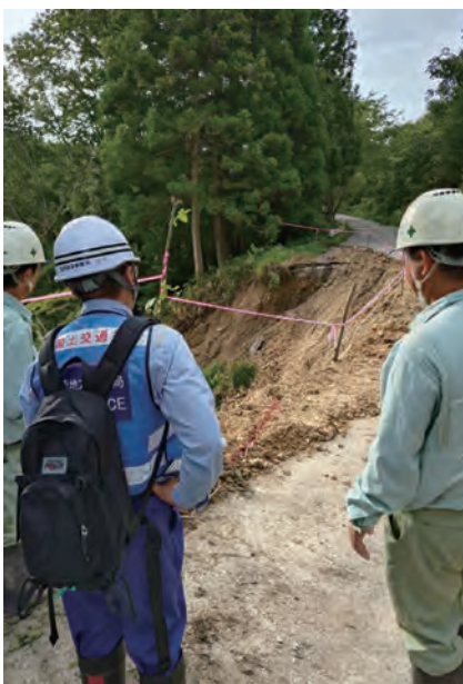
道路の被災状況調査
