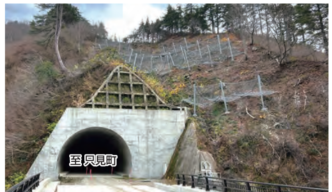
完成した2号トンネル(起点側)の雪崩予防柵
