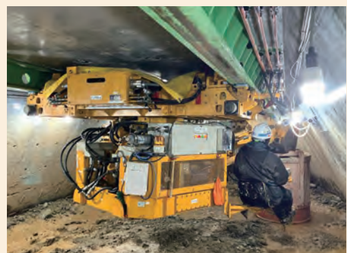
ケーソンシヨベルでの掘削状況(有人掘削)
