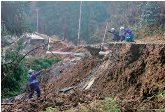
道路の被災状況調査
