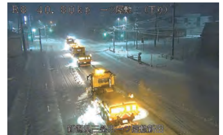
集中除雪実施状況
