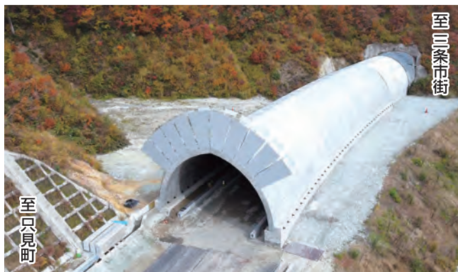
完成した1号スノーシェルター
