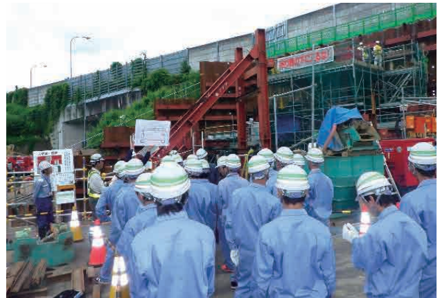
【現場見学会・工事説明<高校生向け>】 南魚沼市 国道253号八箇峠道路
