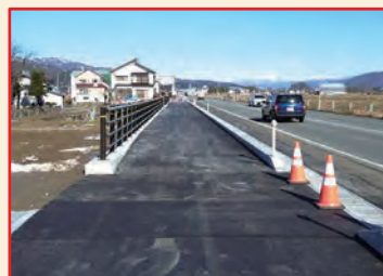
▲完成した歩道
