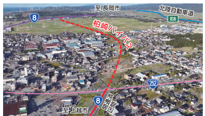
茨目交差点より起点側を望む
