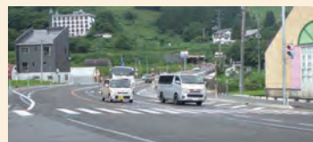
▲右折車線設置区間
