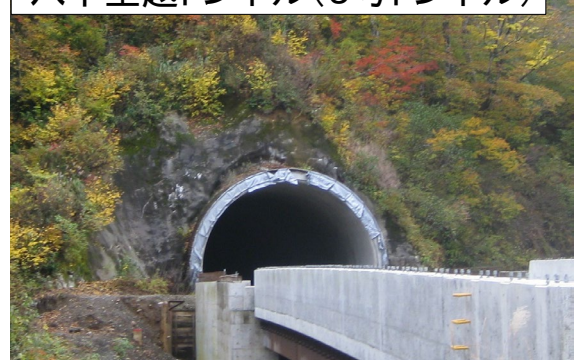
はちじゅうりごえ 八十里越トンネル(9号トンネル)
