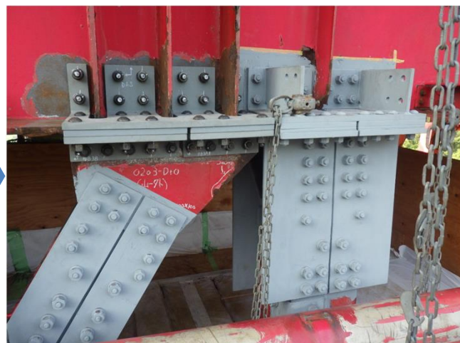
応急対策後①
