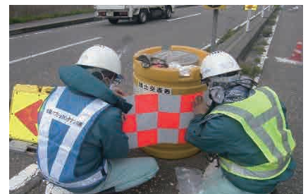
道路施設補修
