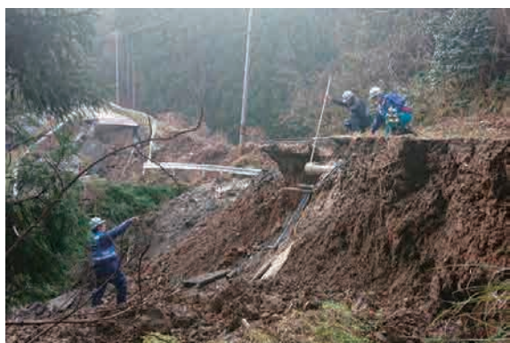
道路の被災状況調査
