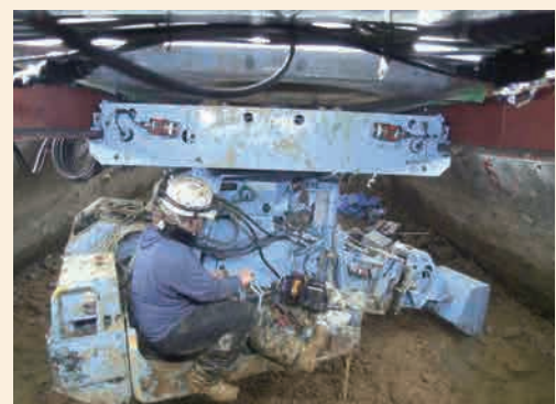
ケーソンショベルでの掘削状況(有人掘削)
