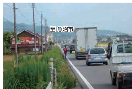
狭い路肩を歩行者が通行し危険
