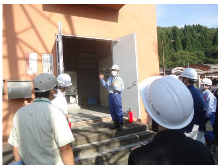
【非常電源用発電機の起動操作】 長岡国道事務所の職員による起動操作方法 の説明
