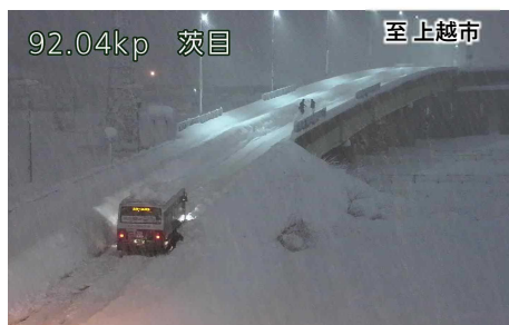
令和4年12月19日 17時頃 R8柏崎高架橋(下)積雪状況
