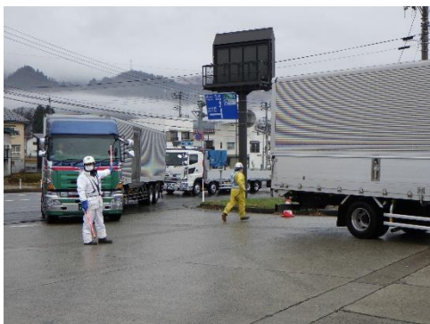
車両の引き込み訓練(令和3年12月7日)
