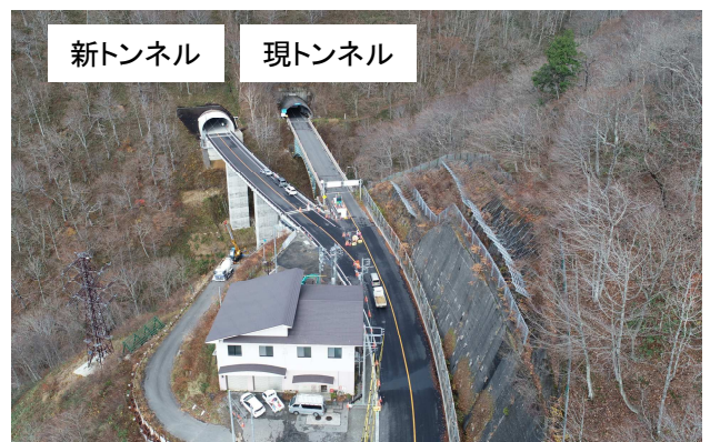
群馬県側坑口付近（R3.11）
