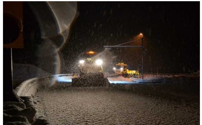
湯沢町湯沢地区 (除雪トラック)
