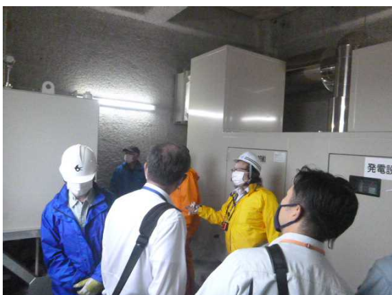
【非常電源用発電機の説明】 長岡国道事務所の職員による 非常電源用発電機の説明
