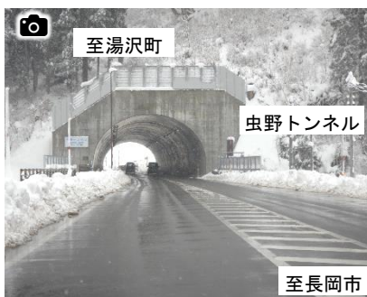
冬期道路状況
