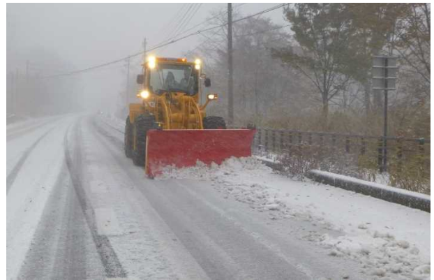
除雪ドーザ（湯沢町三国地先）
