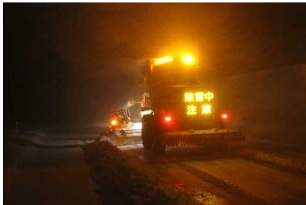
今冬の除雪作業(湯沢町二居地先)
