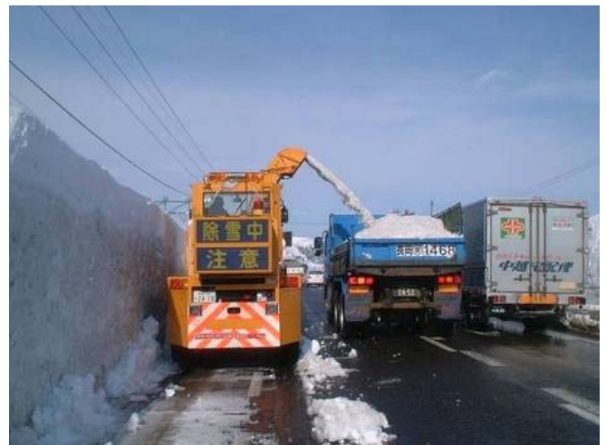
運搬排雪の状況
