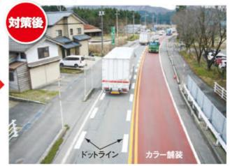
ドットラインによるスピード抑制やカラー舗装による走行区分を明確にする事故対策を実施。
