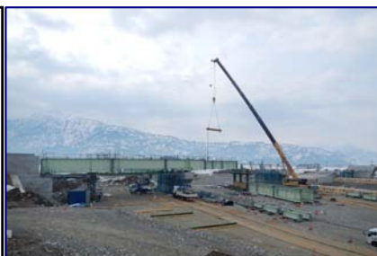
水無大橋の施工状況
