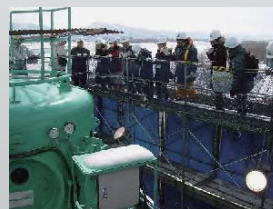
東西道路工事現場の見学
