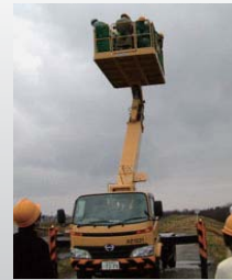
東西道路工事現場の見学
