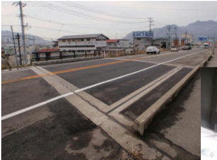
完成(小出4号橋)
