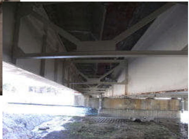
完成(新佐梨橋)
