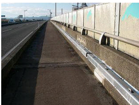
完成(水道町工区)
