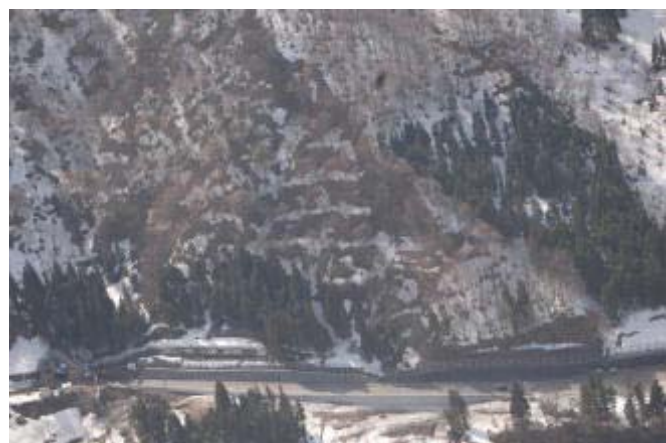
④湯沢町芝原地先(芝原スノーシェッド付近)
