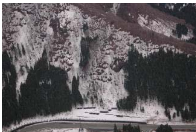
③湯沢町三俣地先(八木沢トンネル付近)
