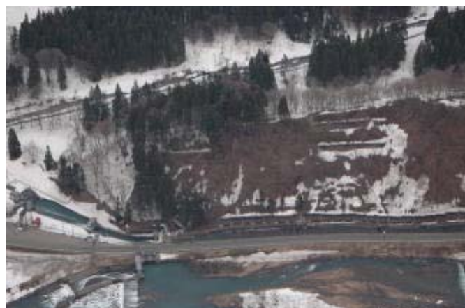
②湯沢町三俣地先(三俣スノーシェッド付近)
