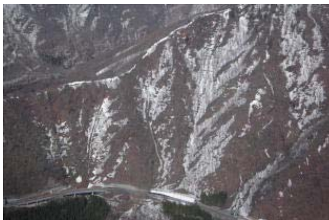
①湯沢町火打地先(火打スノーシェッド付近)
