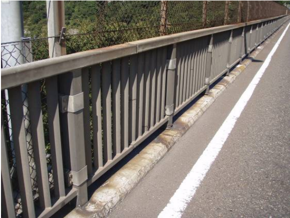
【上輪橋の現況】
