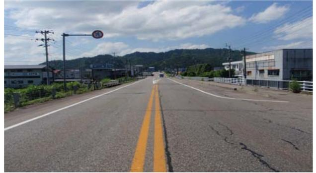
舗装面のクラック損傷
