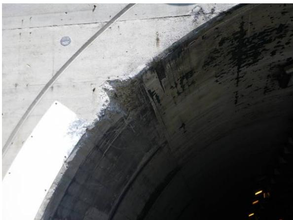
トンネル入口のコンクリートが欠損
