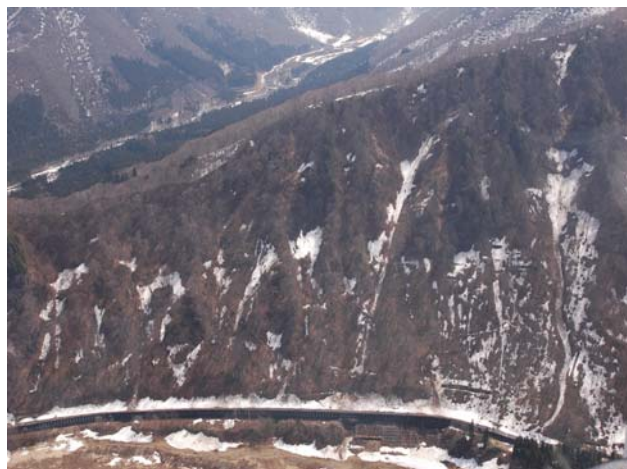
②湯沢町三俣地先(三俣スノーシェッド付近)
