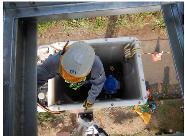
高所作業車 使用状況
