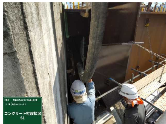
巻立コンクリート打設
