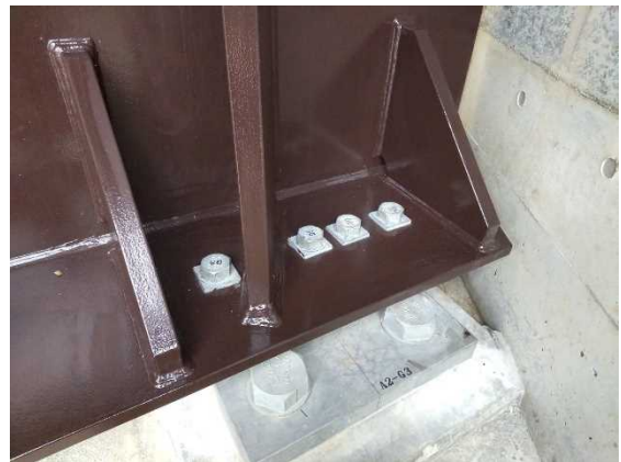
垂直補剛材と近接するため、間隔を変更した支承セットボルト
