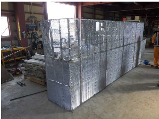
資材庫での型枠組立
