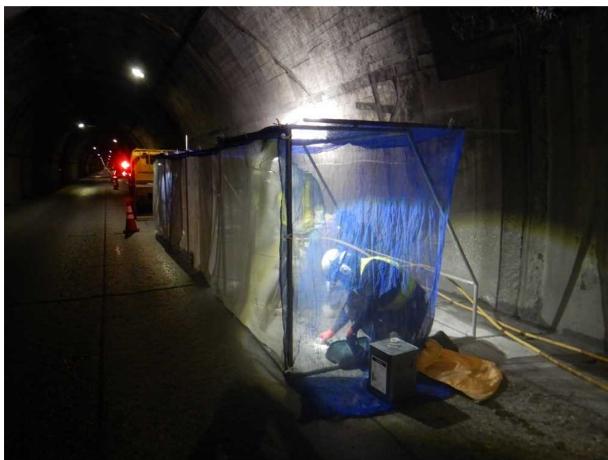
飛散防護柵 設置完了
