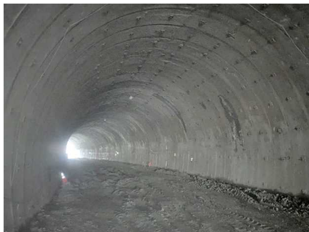
【写真2】吹付けコンクリートの平滑化状況
