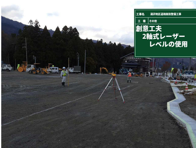
写真ー2 施工状況
