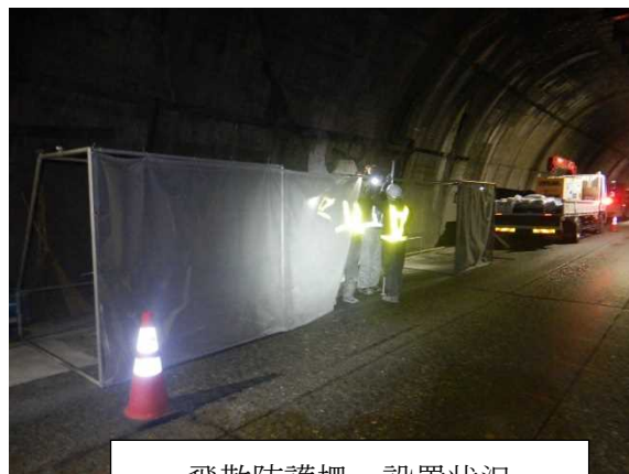
飛散防護柵 設置状況
