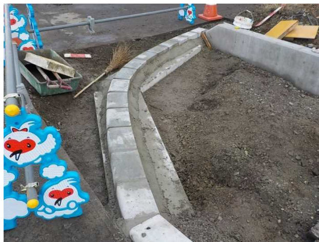
④巻き込み縁石 (Fc-2) 設置完了
