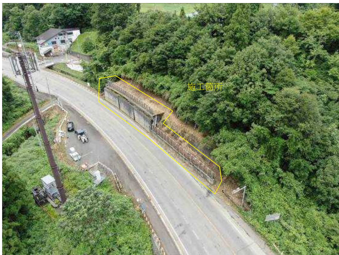
写-1 ドローン測量
