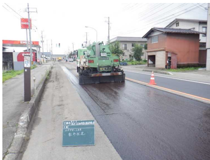
「熱溶着型改質アスファルト乳剤」散布状況
