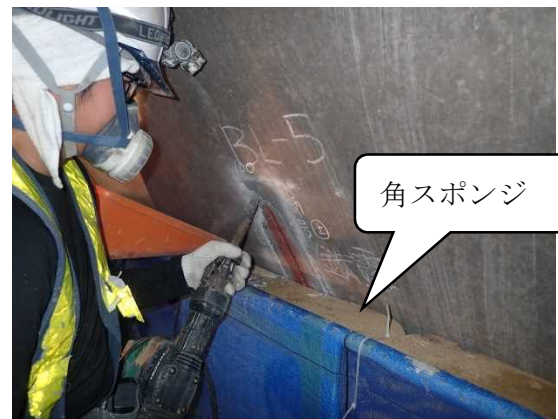
角スポンジ使用
