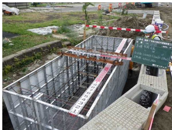
型枠設置完了
