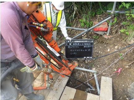
セメントミルク注入状況
