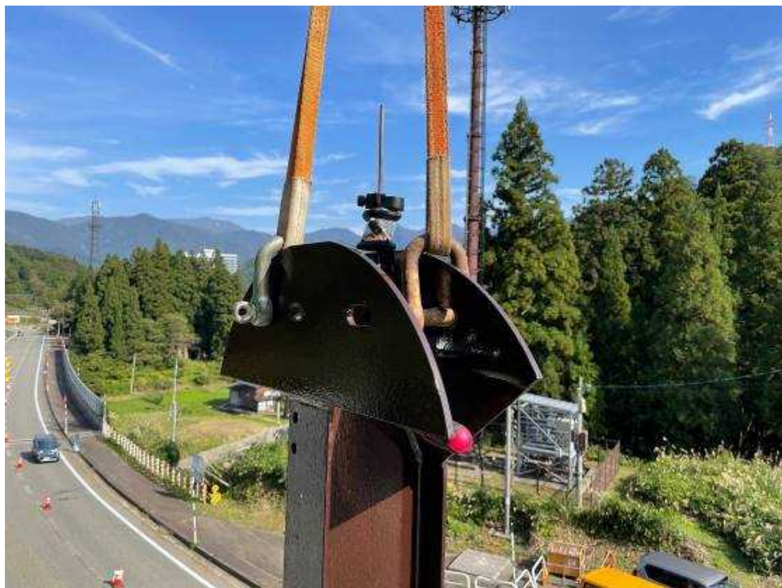
写-4 せり出し防止柵支柱架設状況
