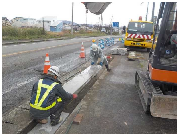
②プレキャスト板（T=10cm）設置状況
