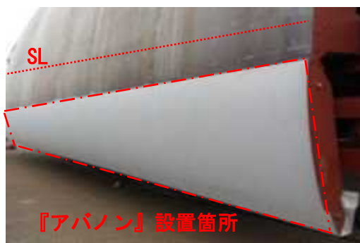
写真-1 透水性型枠用シート(アバノン) 設置位置
