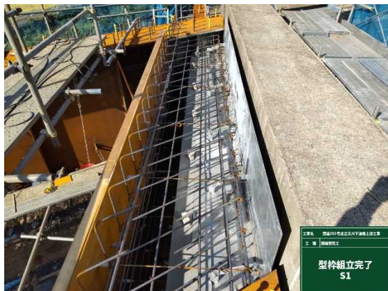
鋼製型枠設置
