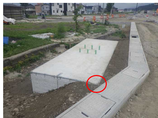
側溝と埋設型枠の離れ10 c m未満
