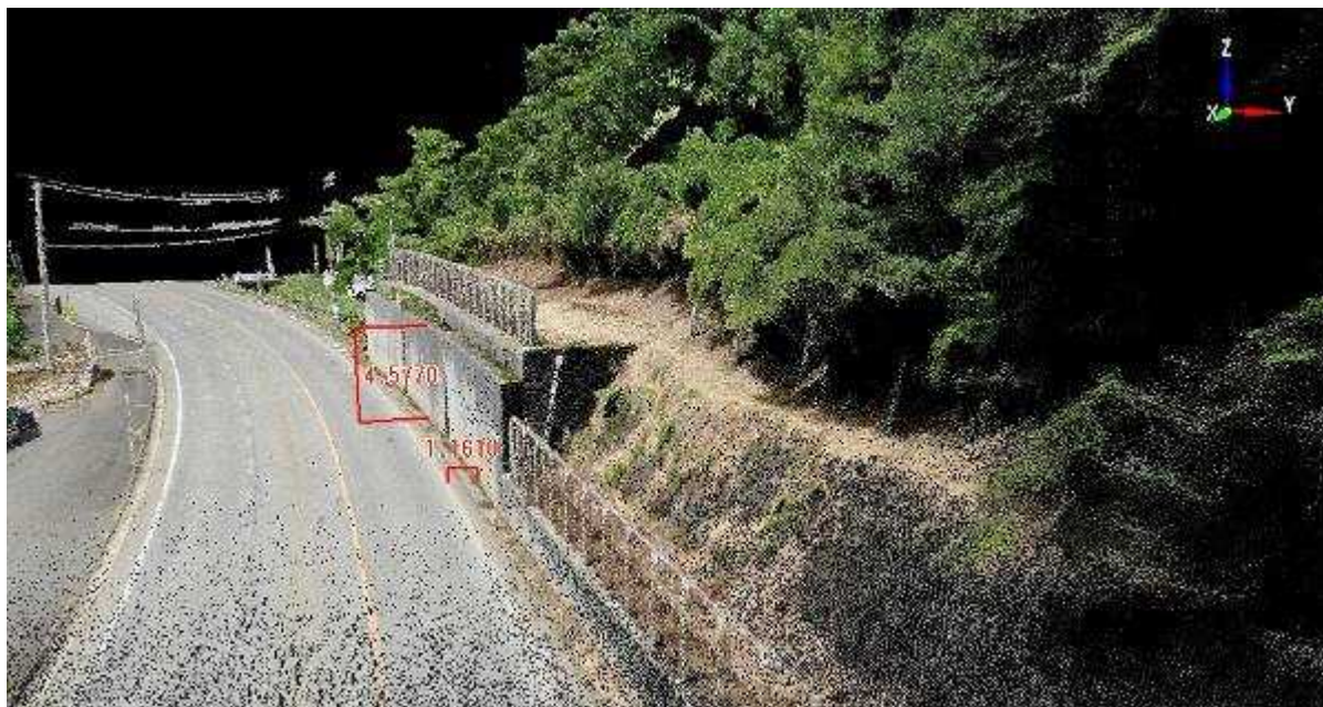
図-1 点群データで再現した現場周辺状況
