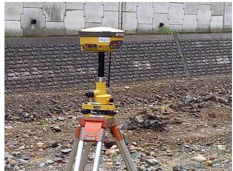
中継器設置状況
