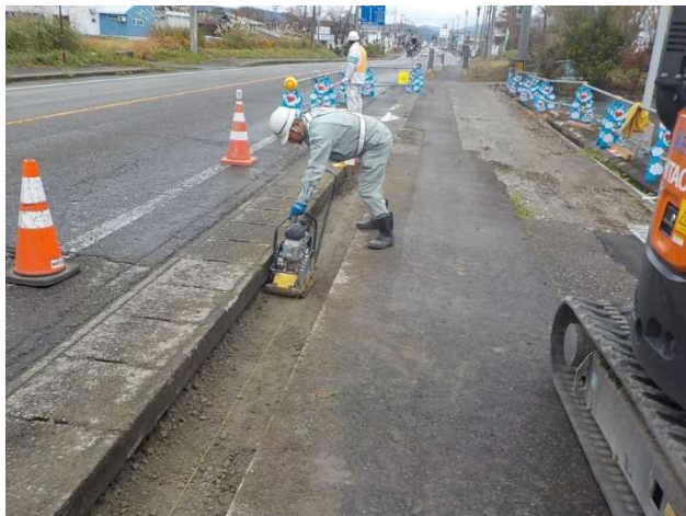
①基礎砕石（T=10cm）施工状況
