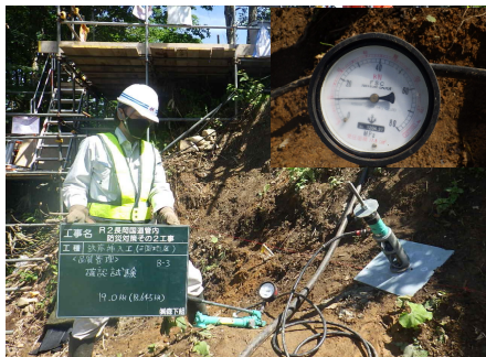
確認試験状況 (設)18.645KN (実)19.000KN
