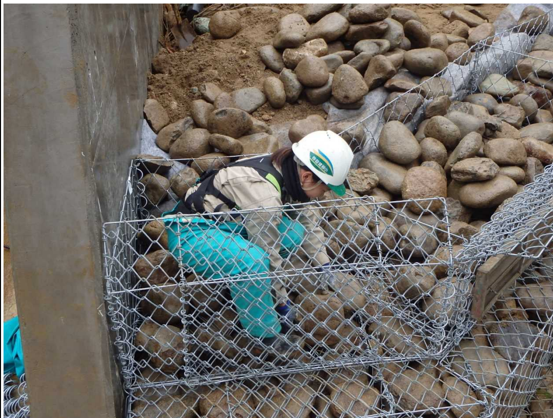
詰石作業状況
