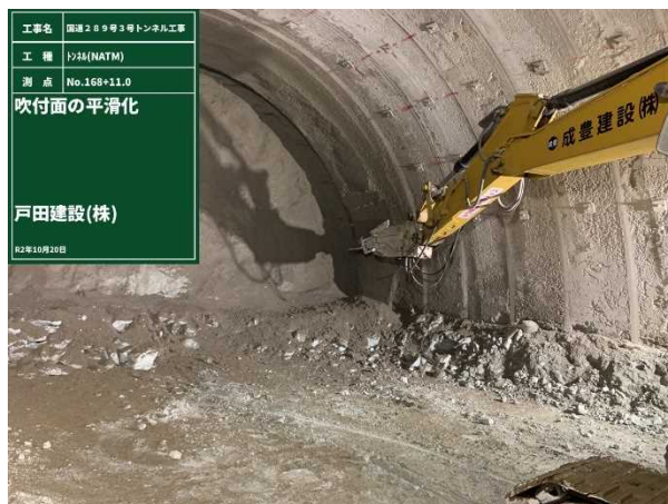
【写真1】吹付けコンクリートの削り取り状況
