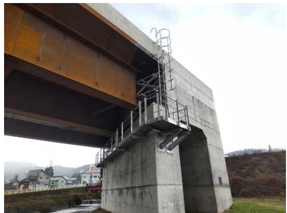
主構造及び橋台に固定する点検路の干渉チェック
