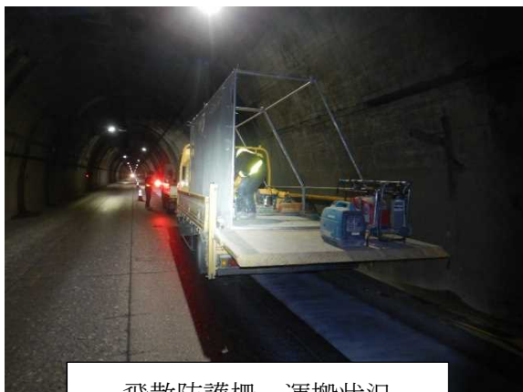
飛散防護柵 運搬状況
