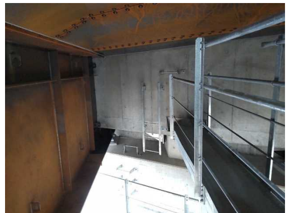
昇降梯子近傍に追加した取手（巻立コンクリート付）
