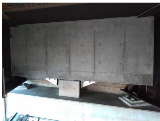
巻立コンクリート施工完了
