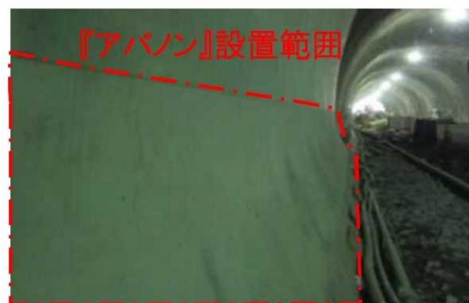
写真-1 透水性型枠用シート(アバノン) 設置位置
