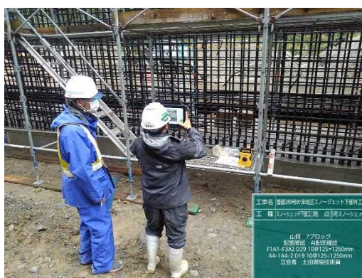
写真1 デジタルデータ方法による出来形計測(5号スノーシェット壁面)
