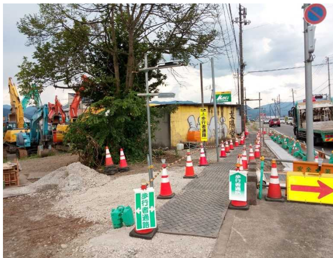
昼間の仮歩道の様子
