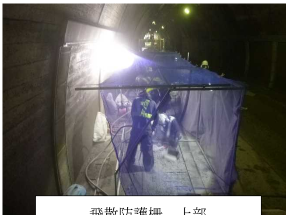
飛散防護柵 上部
