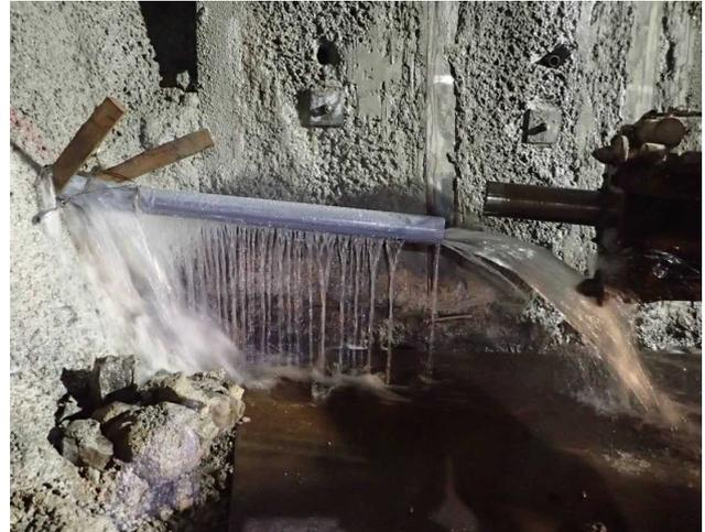
切羽前方水抜きボーリング湧水状況
