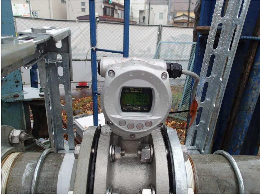
量水器（電磁流量計）による流量測定
