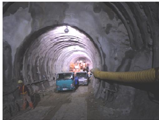
写真-4. ロックボルト施工状況
