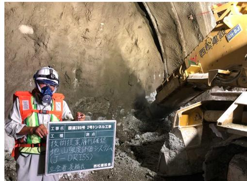
写真-3 自由断面掘削機による掘削状況
