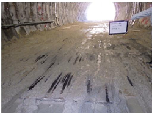
写真-5. 敷鉄板による泥濘化対策
