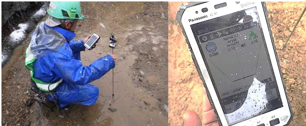
左：自社作業員が横断形状を測量している様子
