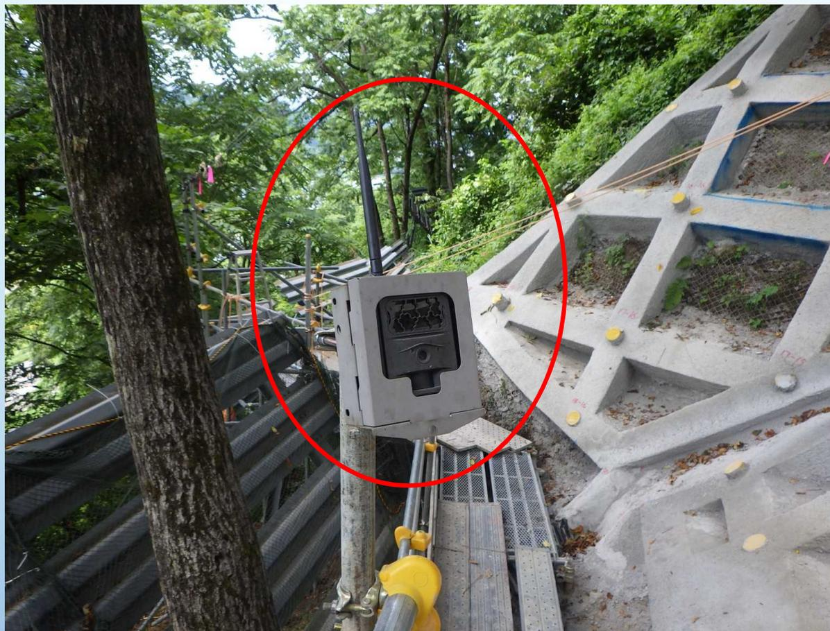
※電源工事不要の乾電池可動式カメラであり小型で軽量。クラウドに保存されるため、事務所にいながら現場状況を確認できる。台風・災害時等の場合でも現場確認が容易のため安全管理にも活用可能。
