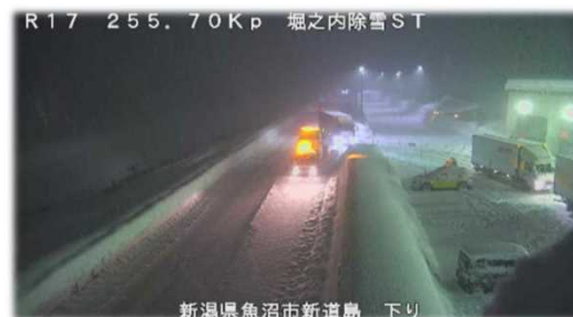
①【通行止め】1月28日 国道17号 新潟県魚沼市
