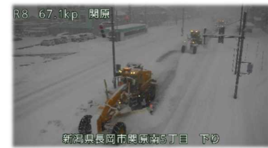
②【集中的除雪】1月26日 国道8号 新潟県長岡市
