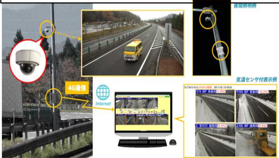
WEBカメラの更なる増設（現在 約250台）
