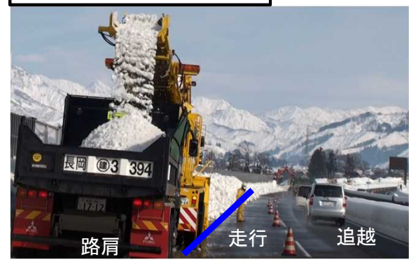
③ダンプ排雪作業状況
