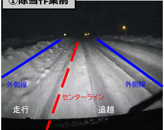
①除雪作業前
