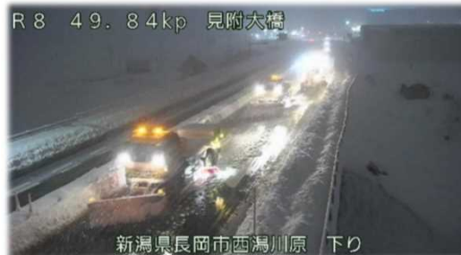
②【集中的除雪】1月28日 国道8号 新潟県長岡市
