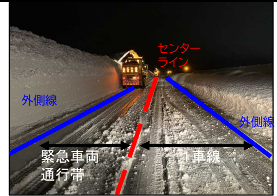
②-1 ロータリー除雪車による拡幅作業を行い1.5車線（1車線+緊急車両通行帯）を確保し通行止め解除を目指す
