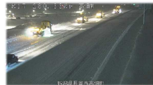
①【集中的除雪】1月26日 国道17号 新潟県長岡市
