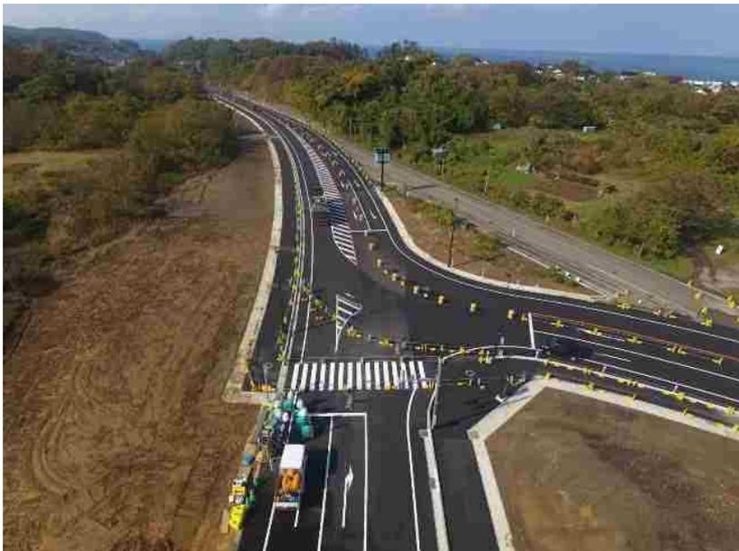
現道すり付け完了からバイパス開通までの交通規制形態
