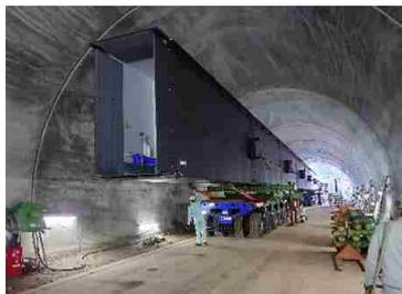
③ 地組桁架設(トンネル内)
