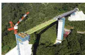
② 鋼桁架設工(送出し)
