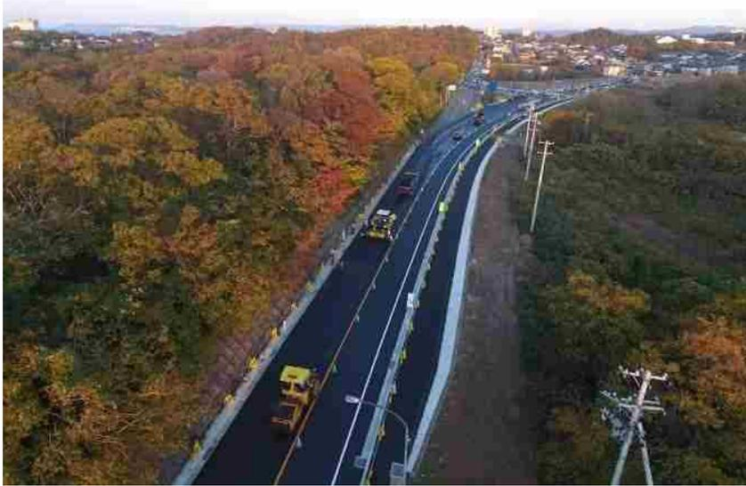
現道すり付け舗装時の交通規制形態
