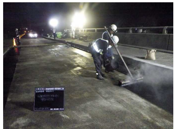
フレッシュコート塗布状況
