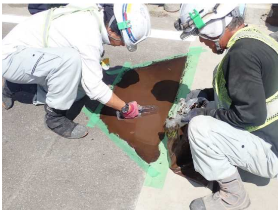
補修材施工状況
