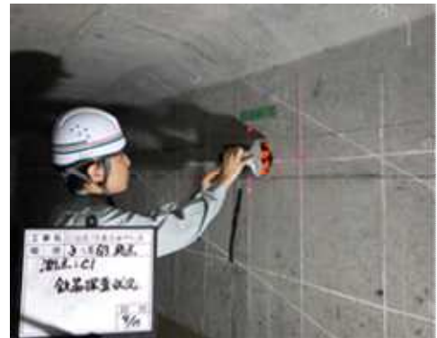
鉄筋探査状況
