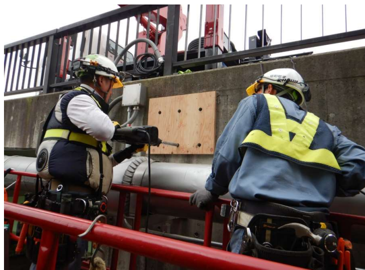
治具を用いた穿孔作業状況
