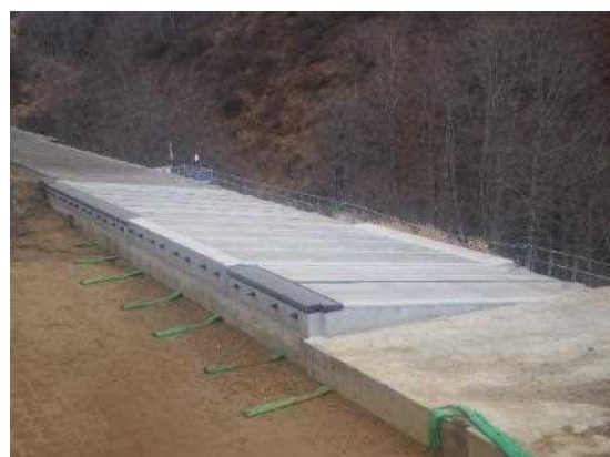
現場完成写真
