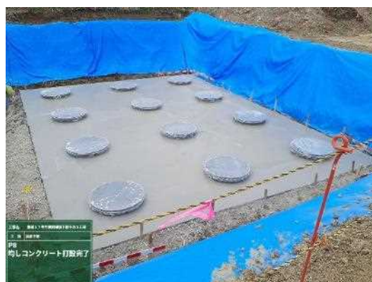
写真 3.1 鋼管中掘り杭
