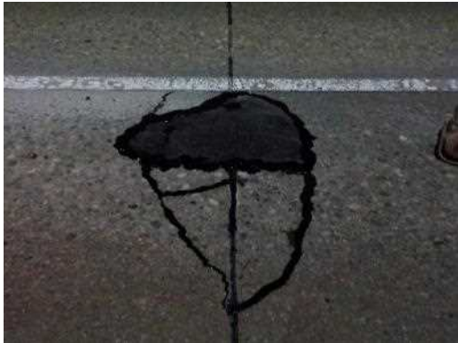
①-3 施工完了
