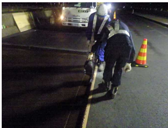
3-2. 表層施工継ぎ目部への防水材塗布 フレッシュコート塗布状況
