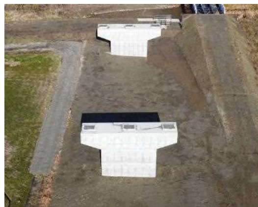
写真 3.2 P8・P9 橋脚(UAV 空撮)
