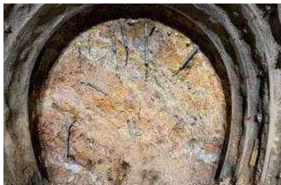
写真-1 切羽写真(導坑先進)
