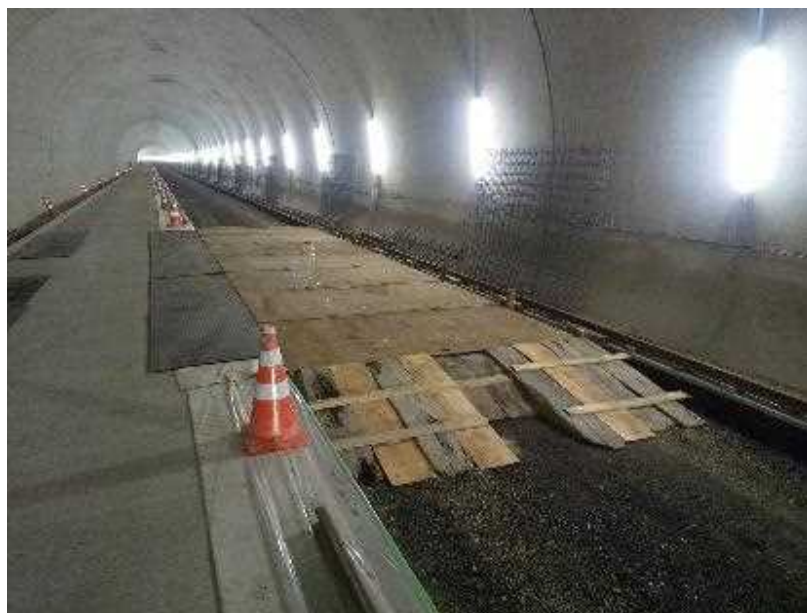
簡易乗入設置状況
