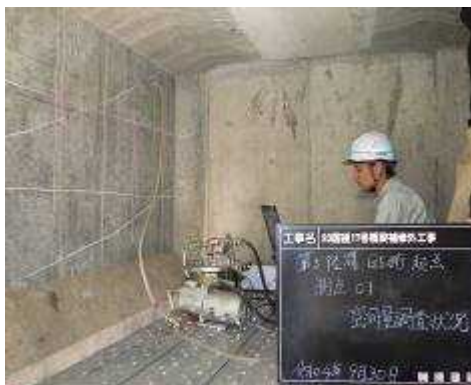
空洞量調査状況
