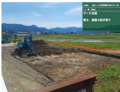
写真 2.2 表土層剥ぎ取り
