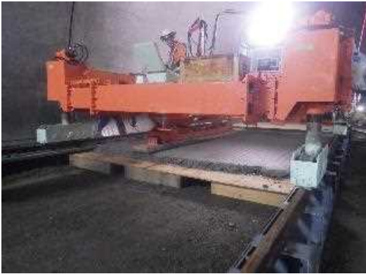
③ 舗装機械を止めずに通過させる
