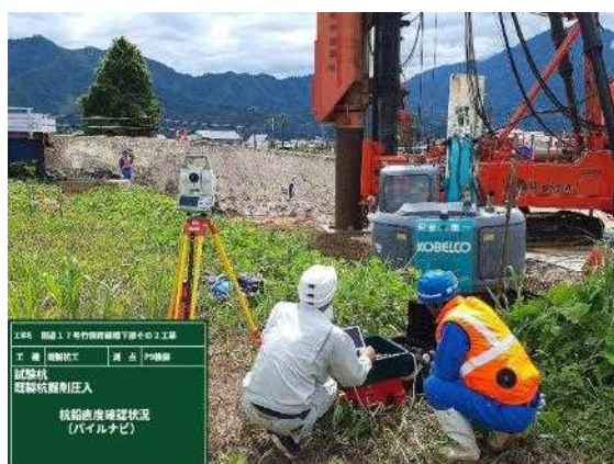
写真 2.4 自動追尾 TS での計測状況
