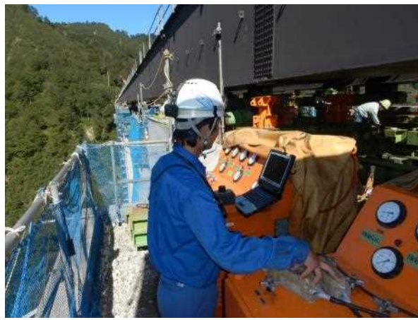
タブレットによる確認（ジャッキ操作員）
