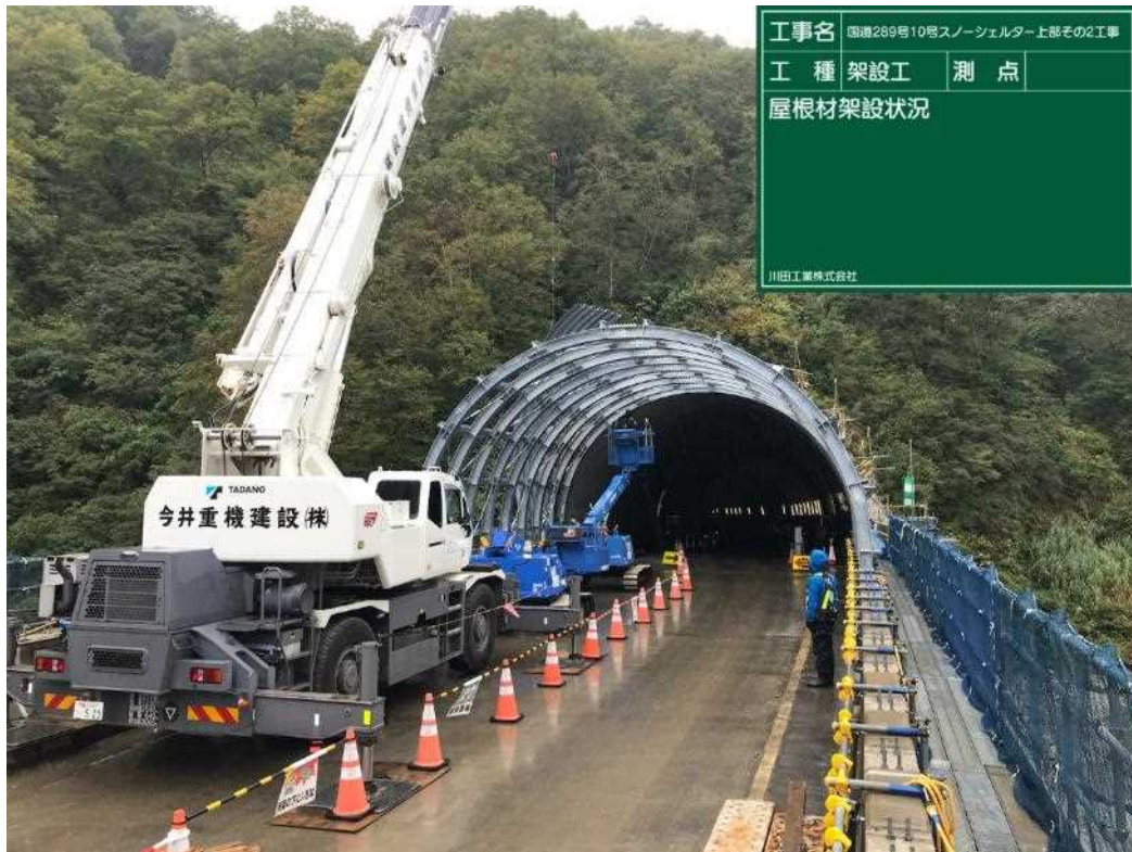
【25 t ラフタークレーンによる屋根材架設状況】
