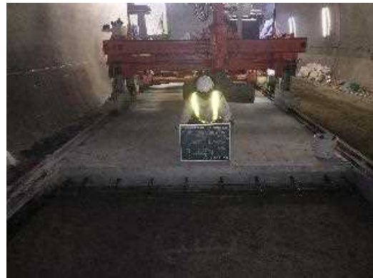
④ 余剰コンクリートを切断撤去
