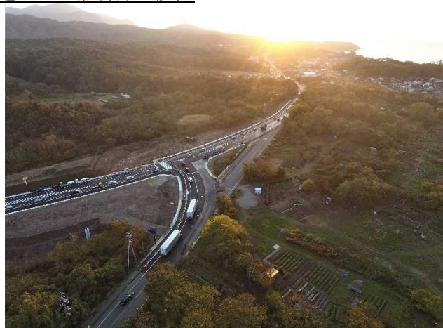
資料-5 現道接続時規制状況
