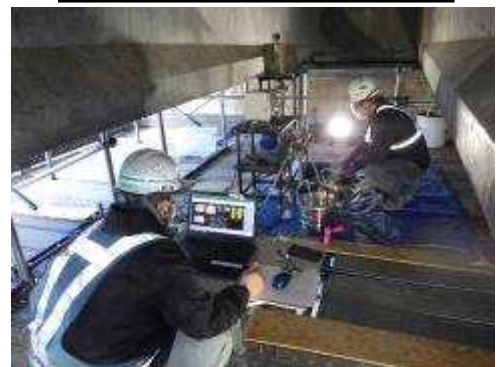
切換え式グラウト再注入施工
