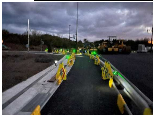
資料-3 ソーラー発電式 LED 照明灯の設置
