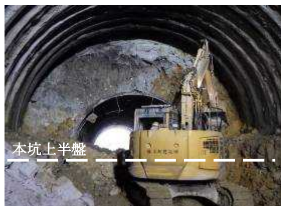
写真-2 作業床の設置
