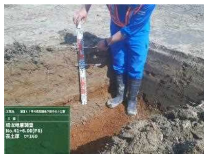
写真 2.1 試験掘削-表土層
