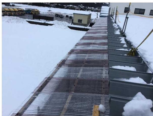
図 4：仮設屋根設置状況(ポリカ波板 上部)
