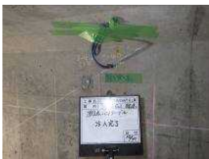
[写真-3 注入完了]
