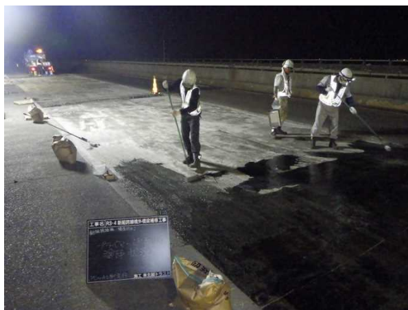
マルチプライマー塗布状況
