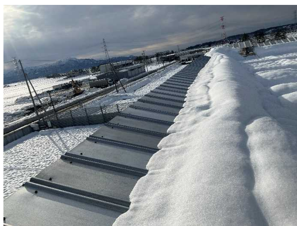
図 2：仮設屋根設置状況(安全鋼板 上部)
