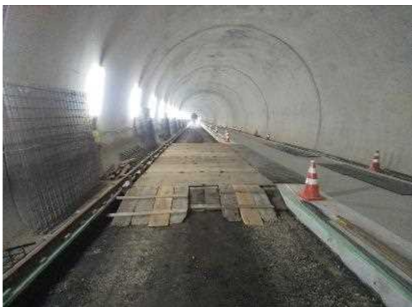
簡易乗入設置状況
