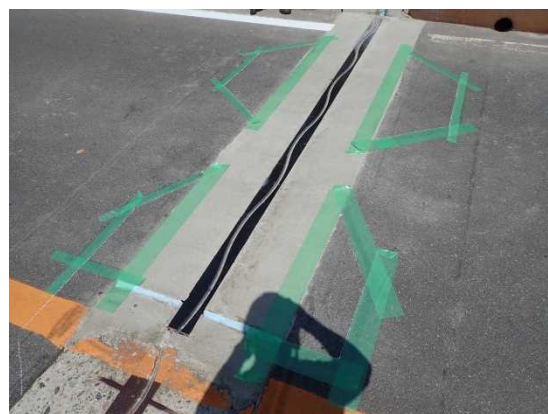
施工箇所養生
