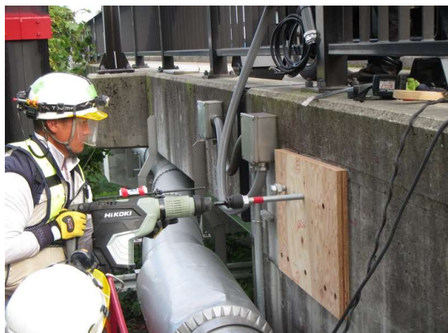
治具を用いたアンカーボルト打設作業状況
