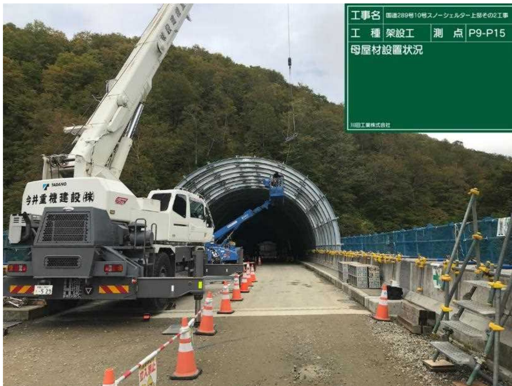
【25 t ラフタークレーンによる母屋材架設状況】
