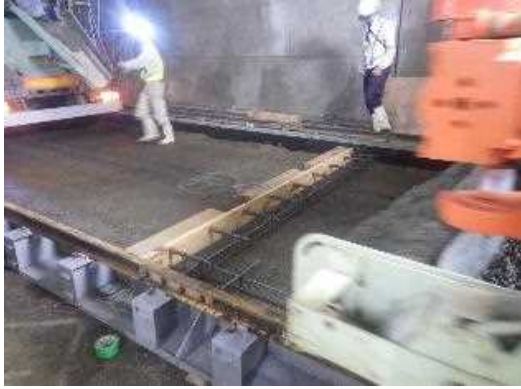
① 仕上りより 8 cm 低く型枠を設置
