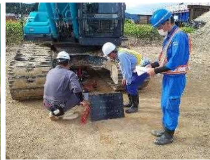
写真 2.3 平板载荷試験
