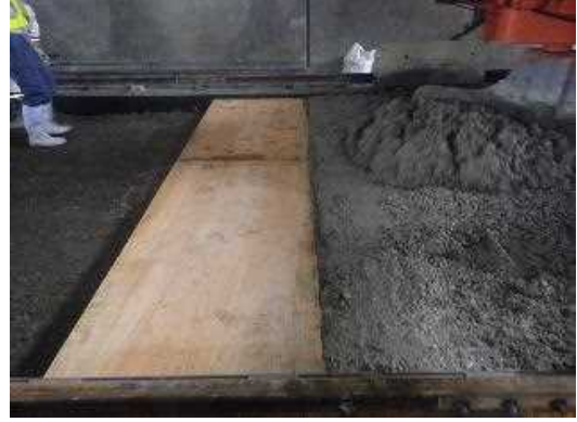
② 余剰コンクリート用ベニヤ板設置
