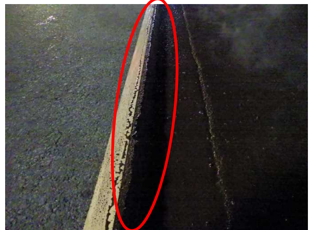
フレッシュコート塗布完了
