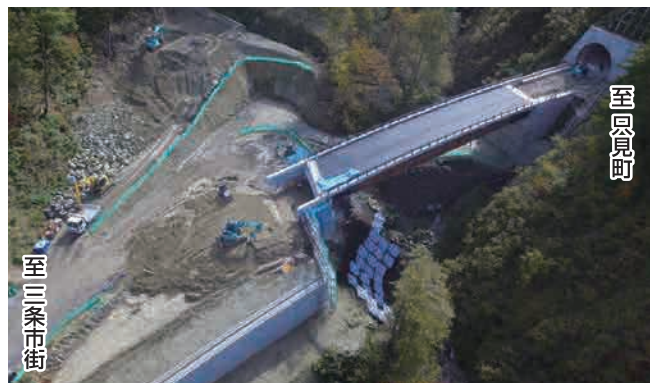
八十里越の橋梁で最後となるB橋梁が概成しました。
