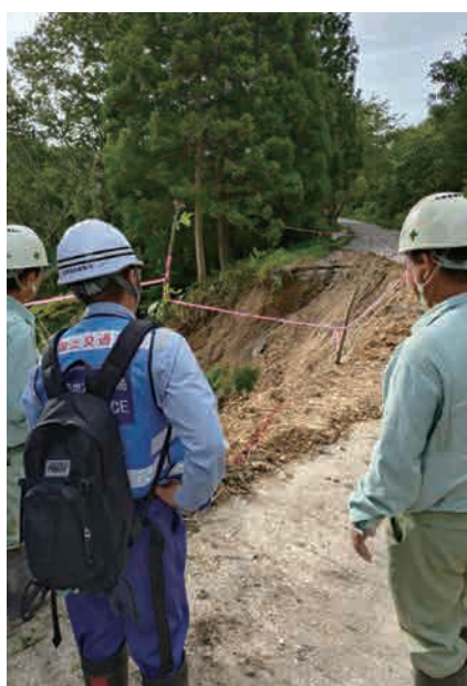
道路の被災状況調査
