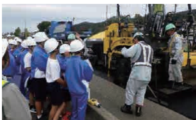
【舗装工事見学会〈中学生向け〉】 長岡市 国道17号
