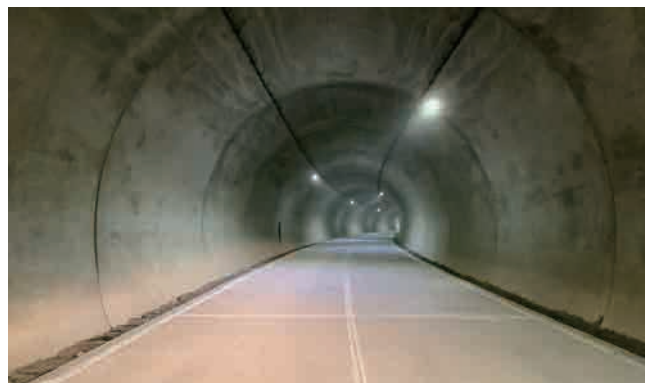
八十里越のトンネル舗装がすべて完了しました。
