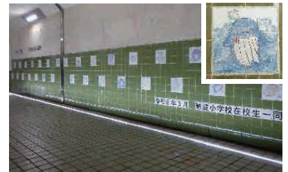
塗り替えを記念して、地下道内部に小学生がデザインした記念タイルを設置
