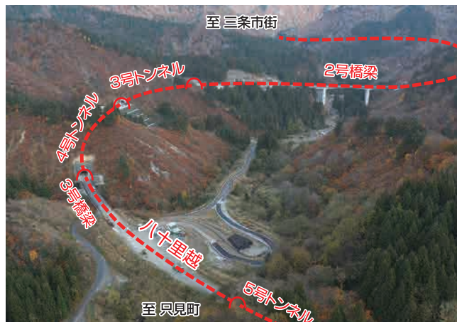
5号トンネルより三条市街方面を望む
