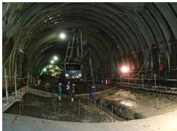
インバートコンクリートの打設状況 (H26.11.15 撮影)
