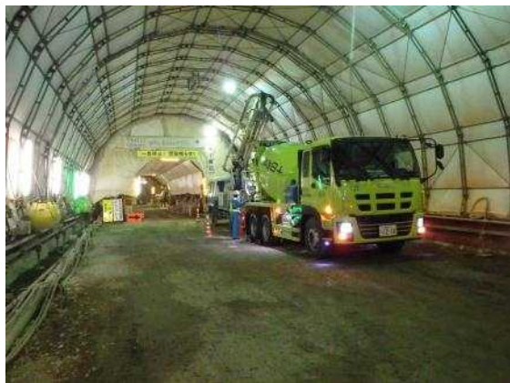
覆工コンクリートの打設状況 (H26.12.26 撮影)
