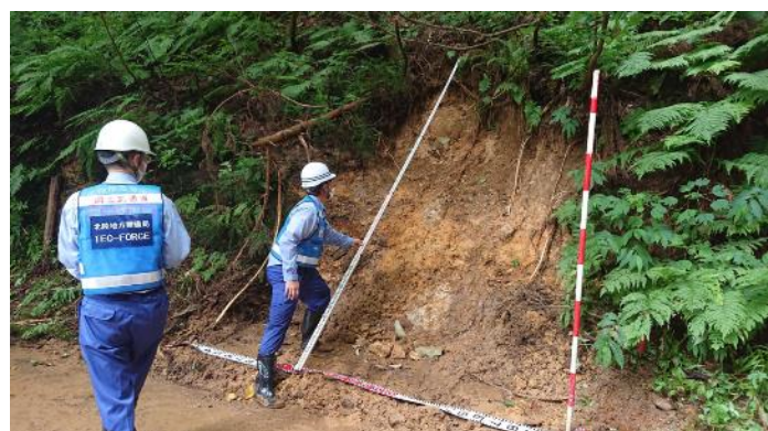
【道路法面崩落状況調査】
