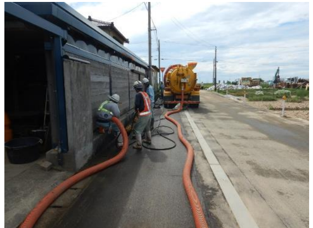
【側溝清掃作業(村上市川部地区)】
