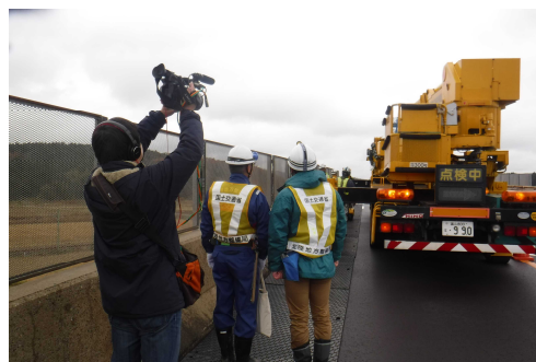
橋梁点検のテレビ取材を受けている状況
