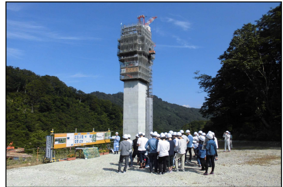
3H工法を採用した5号橋梁の橋脚工事
