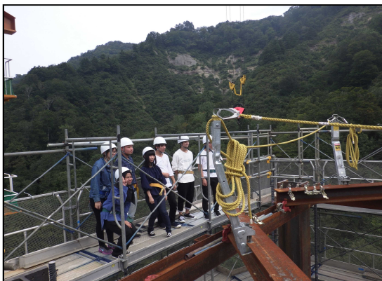
足場最上段から施工状況を見学
