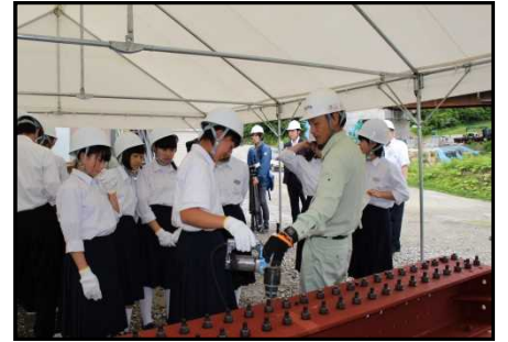
高力ボルトの締め付け作業を体験
