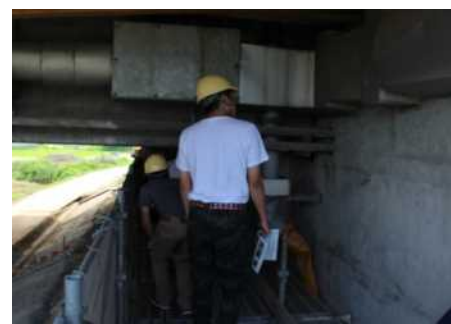
足場内で橋梁補強対策箇所を見学
